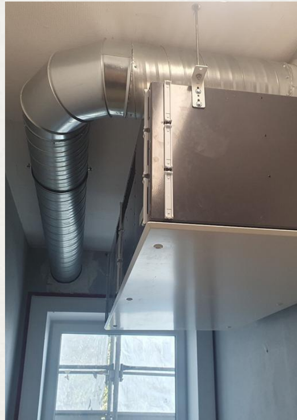
Traitement des étuves
