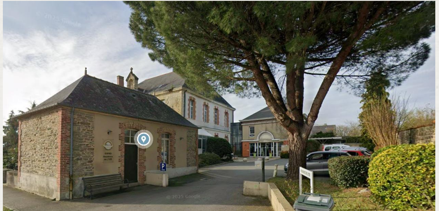
Entrée du site
