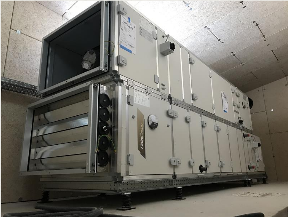
CTA DencoHappel (Fläktgroup) CAIRplus 4160 m 3 /h \eta 83% Ts=22,3°C pour Text=32°C et Ti=26°C/50%
