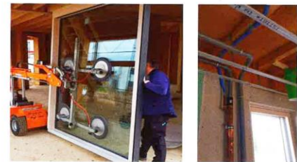
Les menuiseries Bieber équipées en triple vitrage sont impressionnantes en poids !
