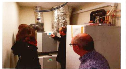
Mise en route de la Air Comfort avec les équipes de Brink.
