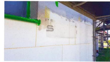
Le système d'isolation par l'extérieur de STO est mis en œuvre.
