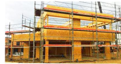
Initialement prévu en maçonnerie, le projet a évolué vers l'ossature bois, matériau de préférence de Maisons Voegelé.
