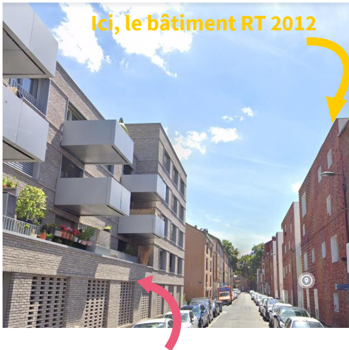
Ici, le bâtiment passif
