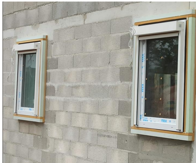
Précadre isolé : pose en applique extérieure
