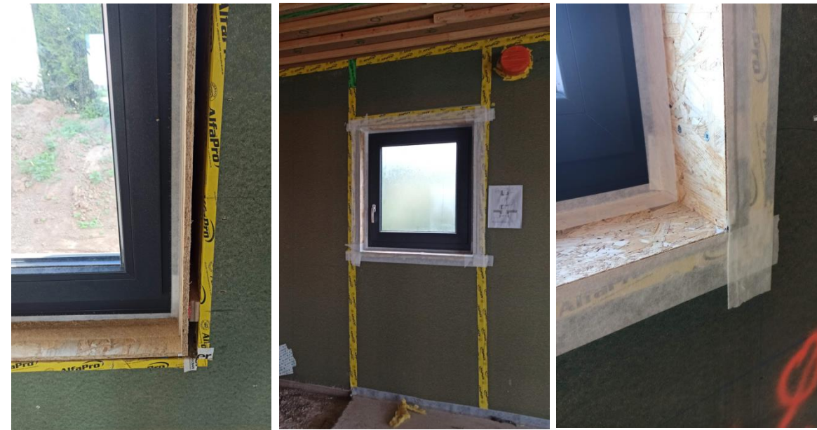
Précadre isolé : pose en tunnel précadre + adhésif
